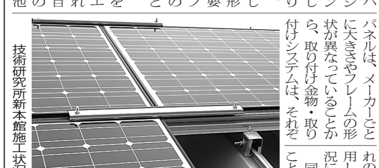
太陽電池汎用取付システムの構造図
