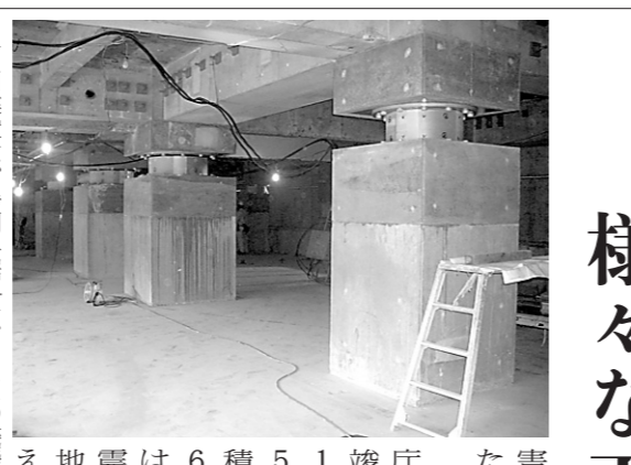
地下空洞充填工事の様子
